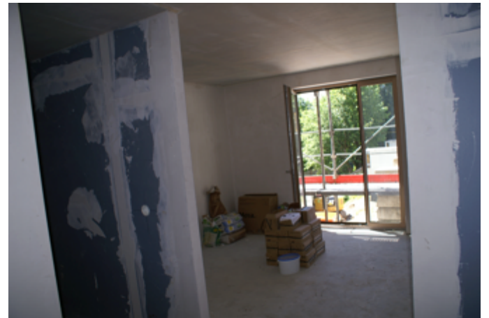
Une chambre. A gauche, l'entrée de la sdb. Au fond, la fenêtre encore sans son garde-fou.
