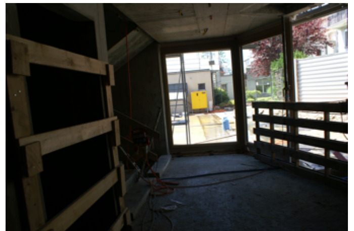
Le palier vu depuis l'entrée de l'unité. A gauche, la cage de l'ascenseur puis les escaliers. Sortie de plain-pied.
