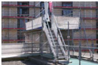
LA PLATE-FORME PLEIN CIEL, DÉMONTÉE À CE JOUR, DERRIÈRE, LE BÂTIMENT C.
