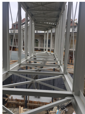
La passerelle depuis le bâtiment D
