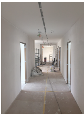
COULOIR 1 ER ÉTAGE DU PAVILLON T
