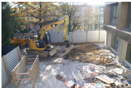
La cour de la piscine /salle de gym en cours de réfection ce jeudi
